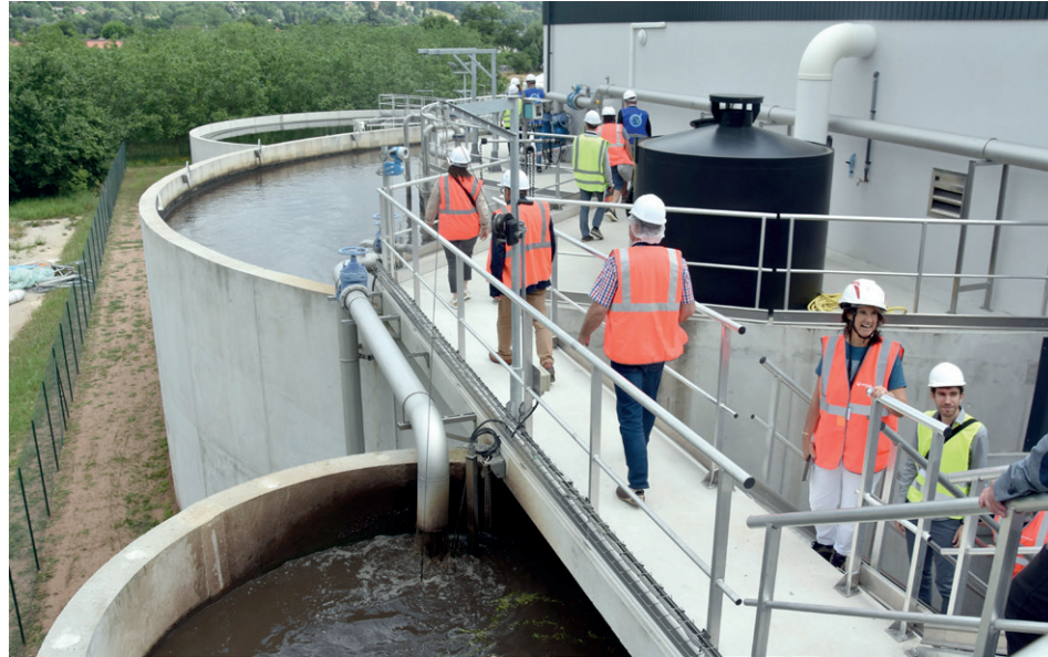
La station d'épuration de Terrasson est désormais équipée pour transformer les eaux usées en eau dite « d'usage » - © DR
